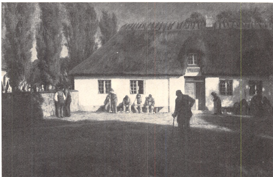
Radsted Hospital. Bygningen opførtes i 1817 og var, som det ses på billedet, bygget helt op til kirkegårdsmuren. Efter maleri af Carl Wentorf 1902. Maribo Stifts Museum.
