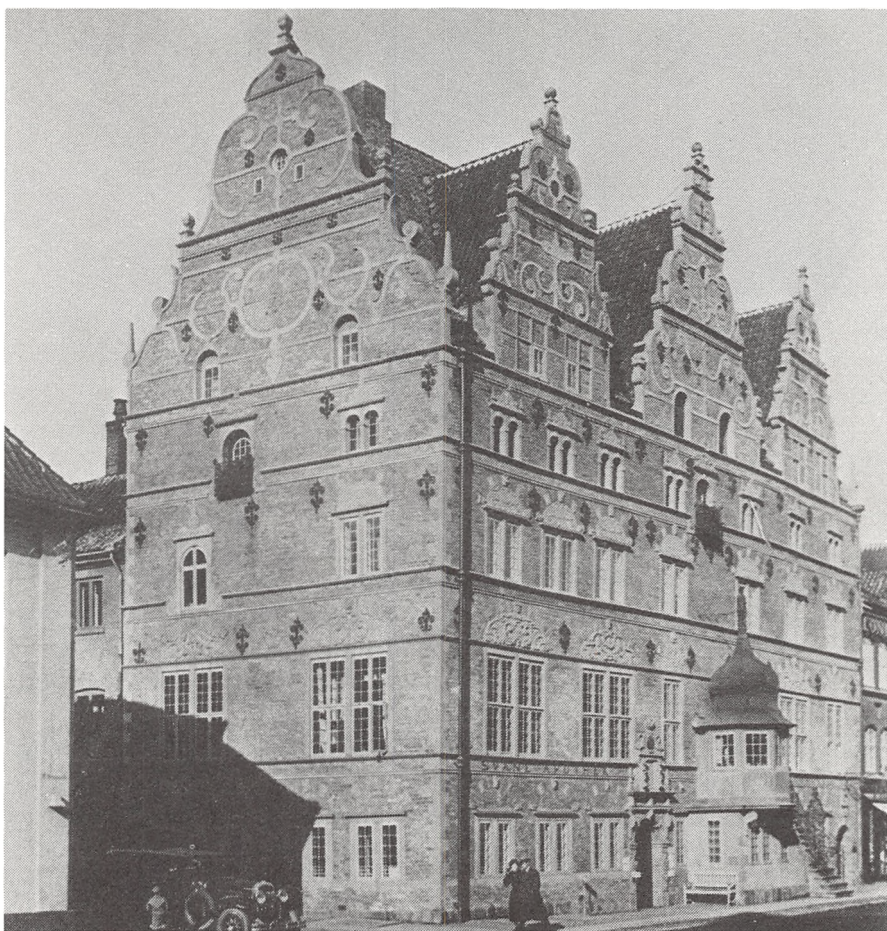
Jens Bangs Stenhus i Aalborg (opf. 1623-24), hvor Svane Apoteket har haft til huse siden 1670. N. K. Strøyberg er født i Stenhuset, hvor hans fader, og før ham, hans farfader havde apotek. Som landets største og mest imponerende renæssancegård er bygningen selvfølgelig fredet.
