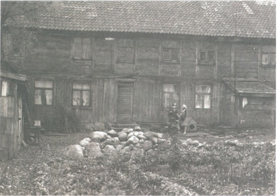
Træhuset, der nu rummer landsbybiblioteket, men som tidligere var min oldemoders og farfaders barndomshjem; fra 1980-erne.
