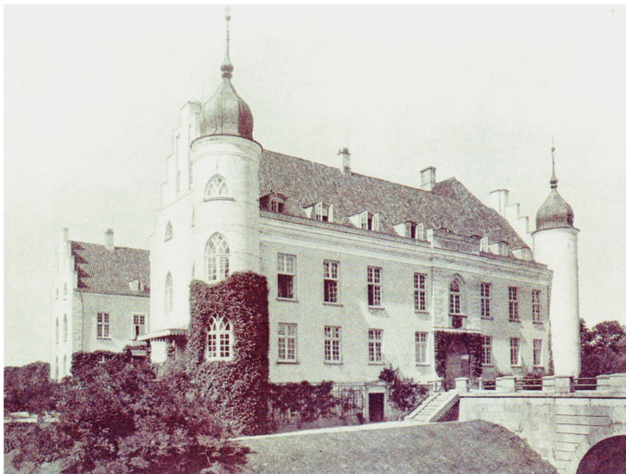
Fig. 4: Hovedbygningen på Krenkerup. I den nordre fløj findes en kælder og to stokværk fra Mogens Gøyes levetid. Mogens Gøyes arvinger fortog en del ændringer op igennem 1600-tallet. Hovedbygningens nutidige udsendende skyldes en gennemgående restaurering i 1830. Det tydelige renæssancepræg er dog endnu tydeligt for eksempel er de takkede gavle en typisk for renæssancens herregårdbyggeri.
